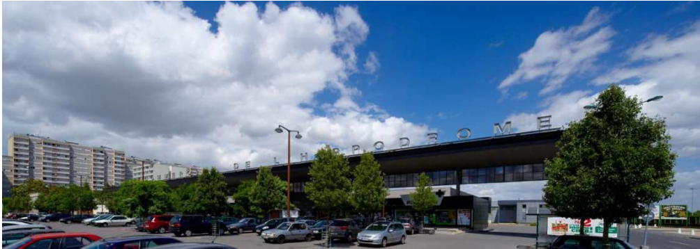
Figure 7 : Photographie du centre commercial de l'Hippodrome, construit pour préparer le remplacement de la passerelle de la Rafale
