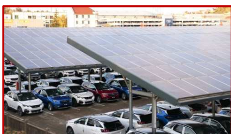
Réalisation d'ombrières photovoltaïques installées sur deux sites : le parking de la Base de Loisirs du Pays de Montbéliard et celui de l'Axone (photo).
