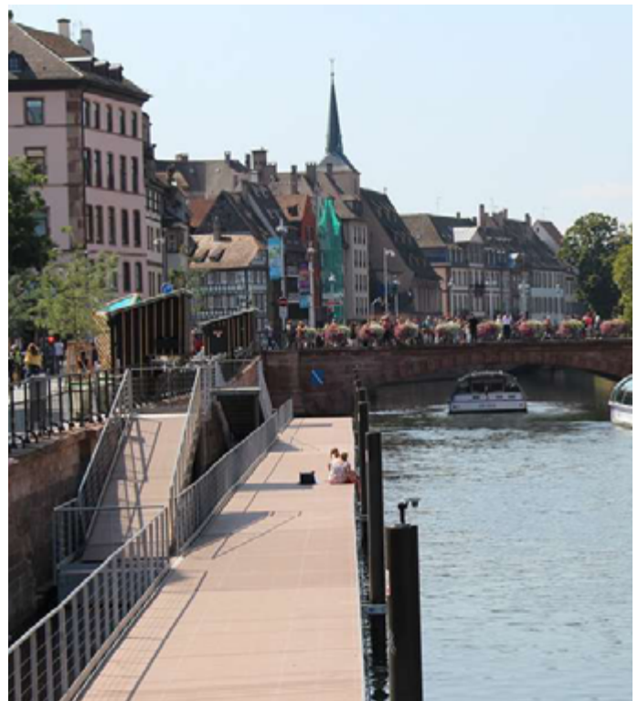
Quai des Bateliers après aménagements, Septembre 2023. Photo personnelle.
