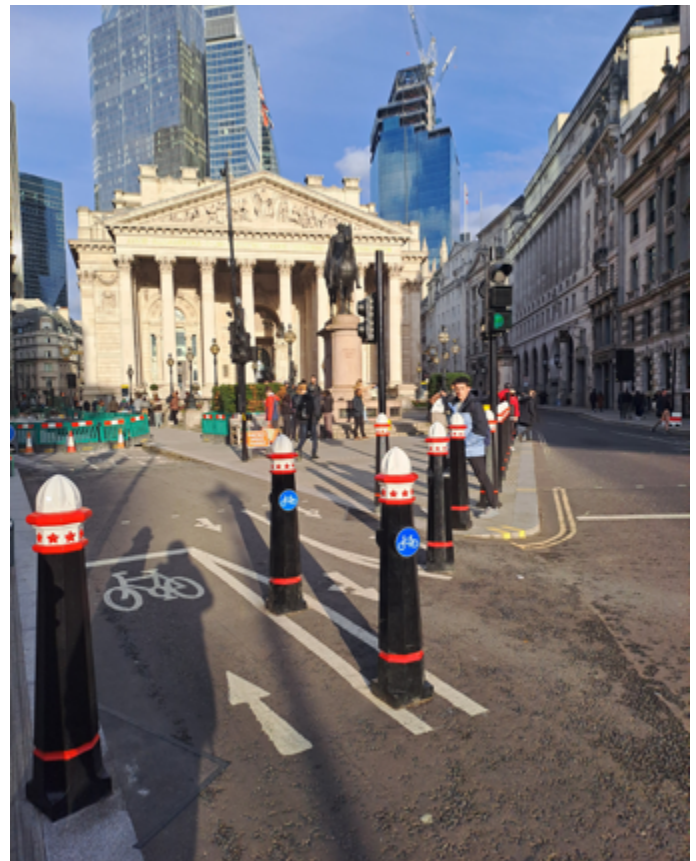
Plots de séparation protégeant une piste cyclable à Londres. Mars 2024. Photographie personnelle.
