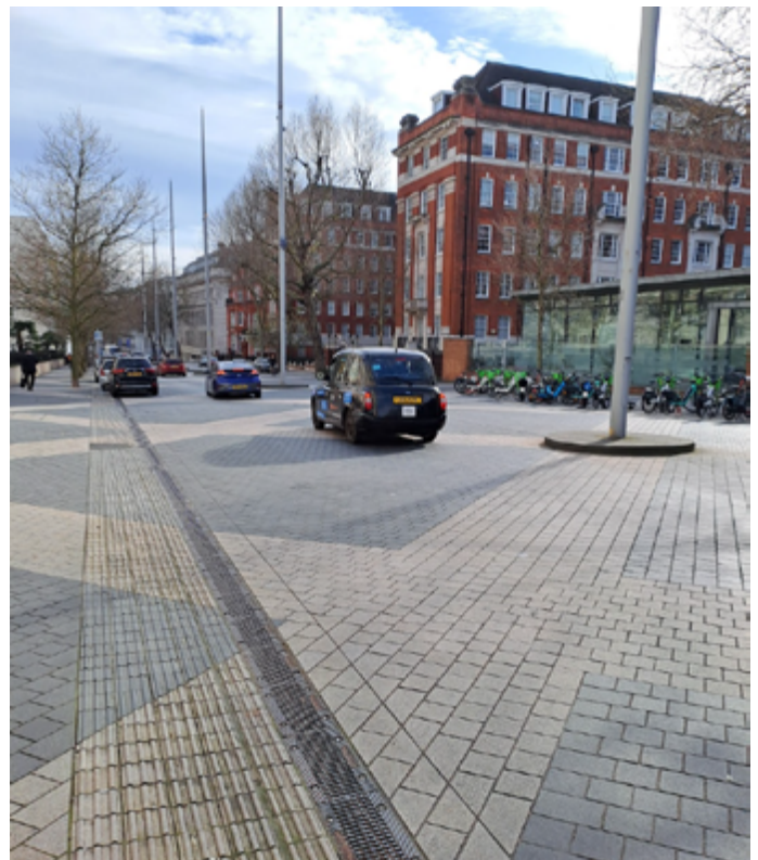
Bandes pour les PMR le long des canaux de drainage, Mars 2024. Photographie personnelle.
