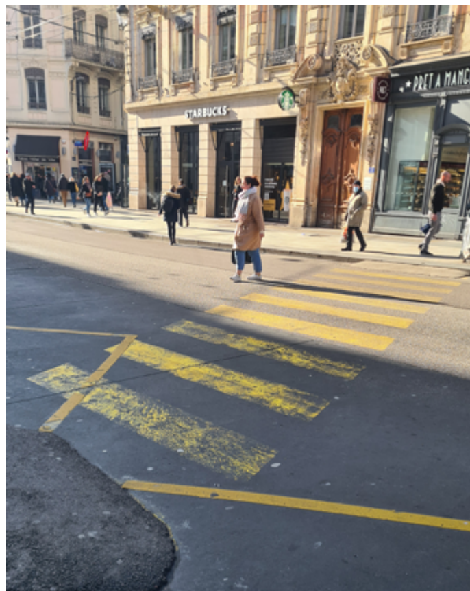
Passage piéton provisoire installé suite à des accidents. Janvier 2024. Photographie personnelle.
